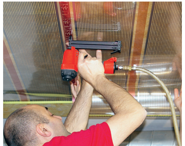
Bei einer Unterkonstruktion aus Holz, klammern Sie die Heiz lien an den Rand- und Mittelstreifen an der Lattung fest.
