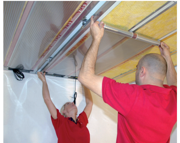
Bei einer Unterkonstruktion aus Metall sind die Heizfolien einem doppelseitigem Klebeband zu befestigen. Die Befestigung erfolgt an den Rand- und Mittelstreifen.
