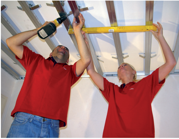
Montage einer Metallunterkonstruktion. Hierzu sind die entsprechenden Vorgaben zur Errichtung einer Metallunterkonstruktion zu beachten.
